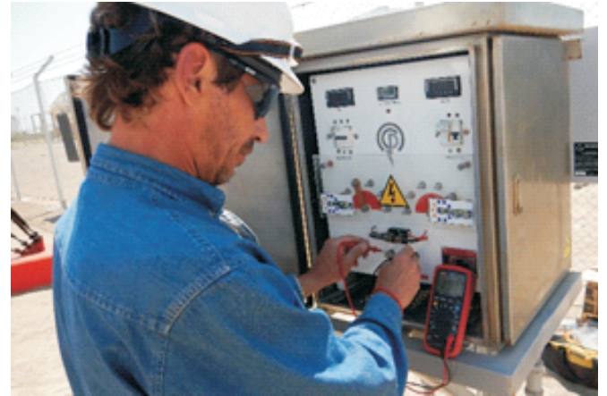
Instalación Sistema de Monitoreo
