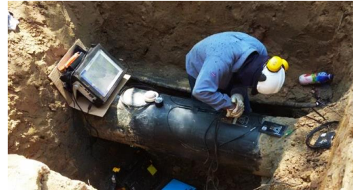
Instalación de Sensores VWSG en ducto
